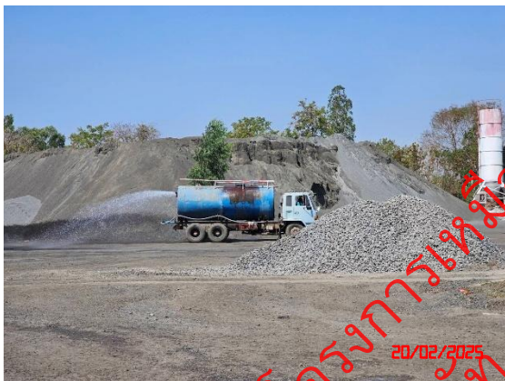
รูปที่ 5 การฉีดพรมน้ำเพื่อลดผลกระทบด้านฝุ่นละออง
