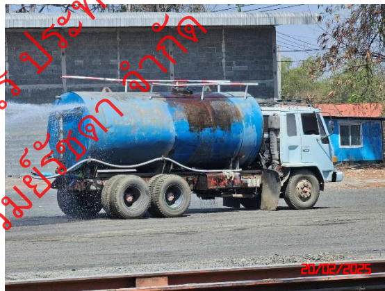
รูปที่ 5 การฉีดพรมน้ำเพื่อลดผลกระทบด้านฝุ่นละออง
